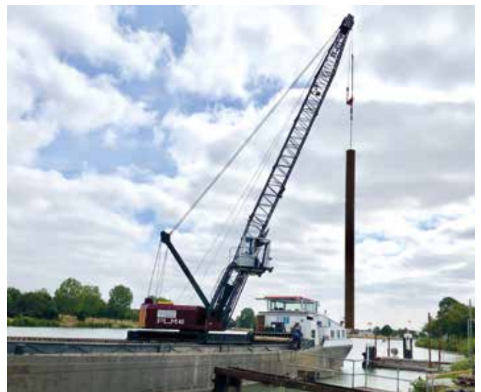
Der neue Dalben wird zum Rammen vorbereitet | Bilder: DVS
