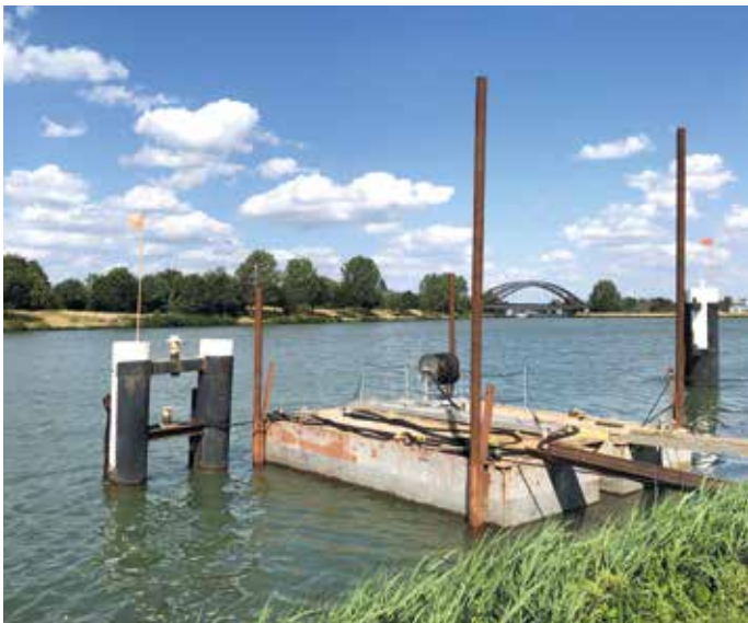
Der provisorische Steg ermöglicht das Bunkern während der Reparaturphase
